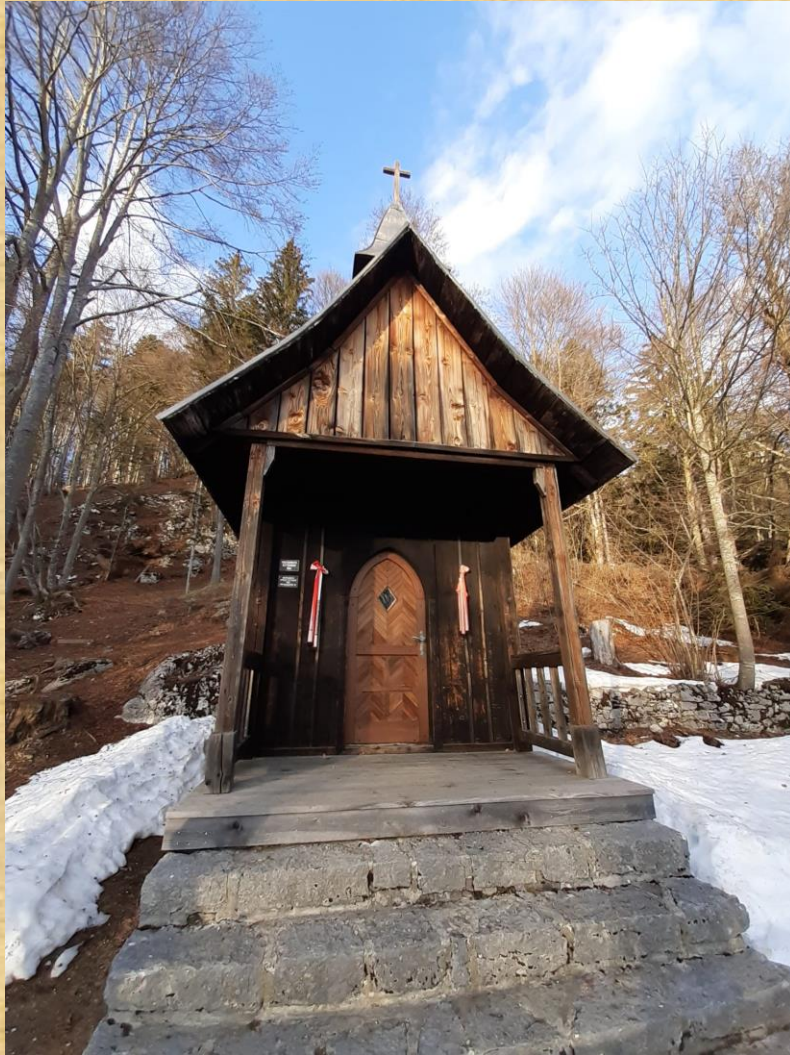
CHIESETTA MILITARE del cimitero di Slaghenaufi
