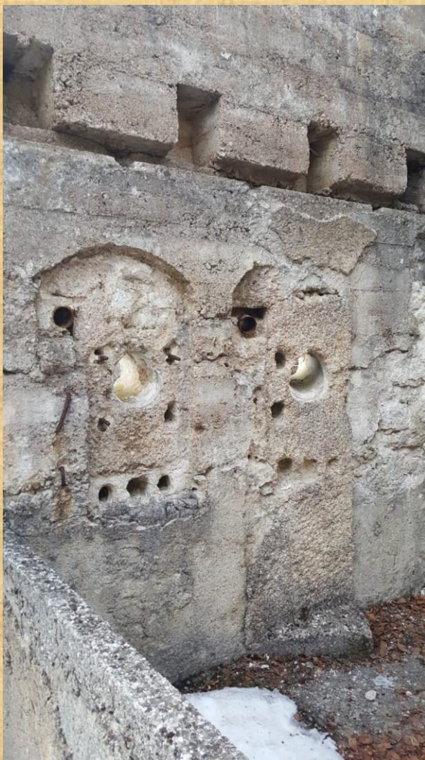
Fori di osservazione e di segnale luminoso
