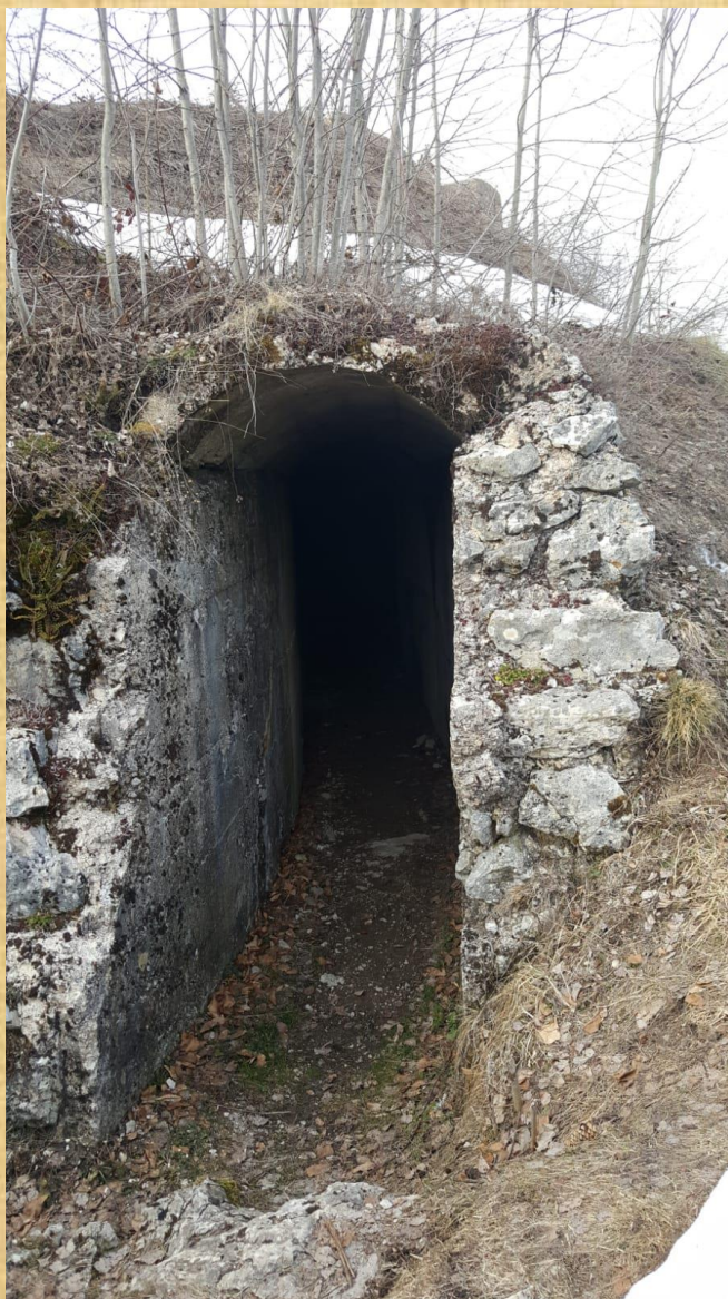
Cunicoli sotterranei dell'osservatorio (che servivano per protezione da eventuali bombardamenti)
